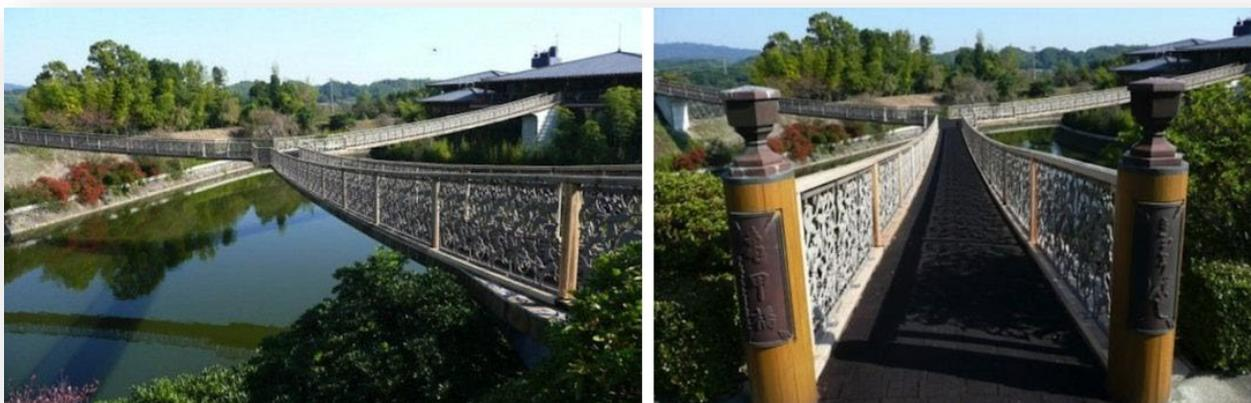
2Ж – отсутствуют опоры у мостового полотна
