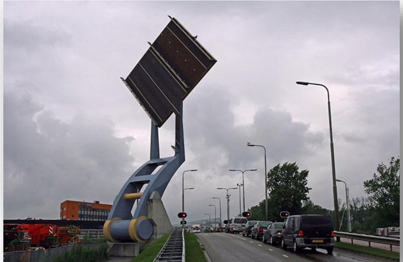
большой интенсивности судоходства и такого же объема транспортных средств, страна нуждалась в мосте, который в состоянии быстро подняться и опуститься, приносить пользу и дороге, и речному судоходству. Так и появился мост Слауэрхофбруг. Построенный в 2000 году из железа и стали, мост поднимается и опускается 10 раз в день с использованием гидравлики.
