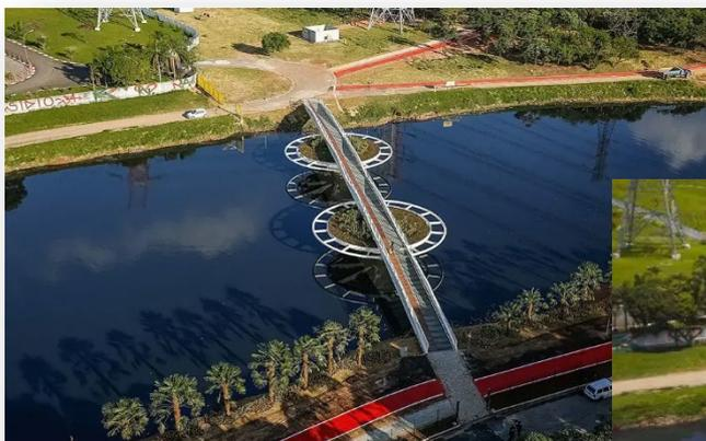
центральная часть которого поворачивается в сторону, создавая удобный судоходный канал шириной 12 м.
